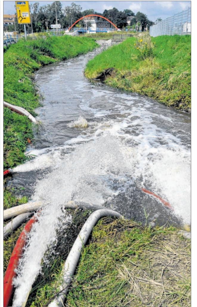
Pumpen, pumpen, pumpen: 35 000 Liter Wasser pro Minute werden aus dem Rückhaltebecken über den Stadtgraben in den Ryck abgeleitet.
