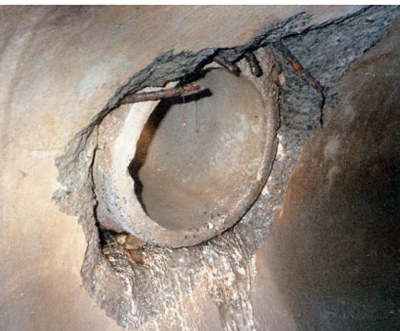
△ **Abb. 4** Defekte Anschlüsse sind ein Dauerproblem in deutschen Abwassernetzen.
